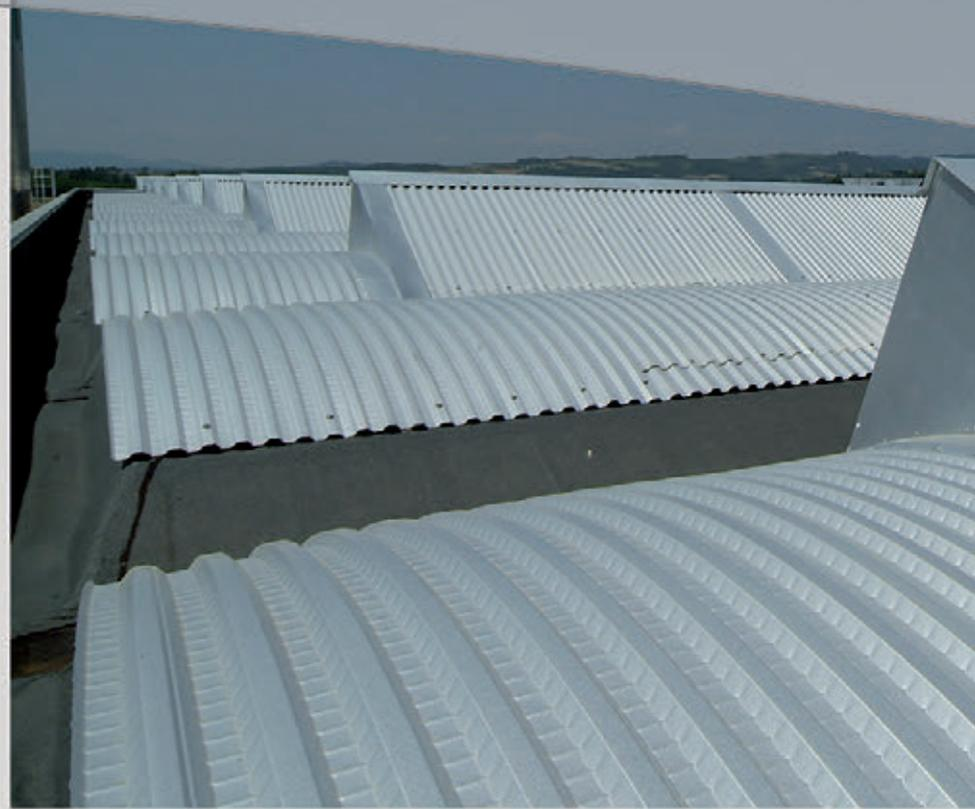
Particolare rilievo riveste la caratteristica, sempre più richiesta, di una grande capacità di ricezione delle acque meteoriche, nelle due direzioni principali dell'edificio, che garantisca l'efficacia anche per le improvvise brevi ma violente precipitazioni; in particolare questa tipologia offre la
