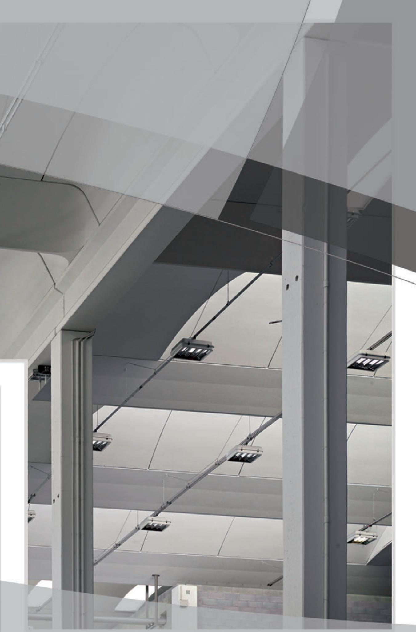
Particolare rilievo riveste la possibilità progettuale di realizzare **maglie strutturali dei pilastri di notevoli dimensioni: m 25,00 x m 25,00** e, in particolari casi, anche maggiori.
